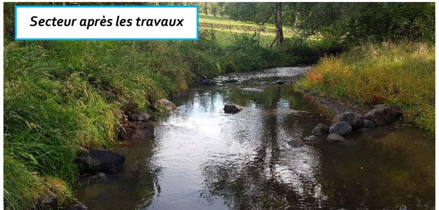
En 2019 une dernière phase d'intervention a consisté à diversifier les écoulements sur le tronçon en réemployant les blocs issus de la déconstruction du seuil, ceci permettant d'accroître les surfaces de caches.
